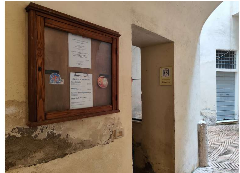
7 Seconda corte interna in direzione dell'ascensore: indicazioni di piccola dimensione
