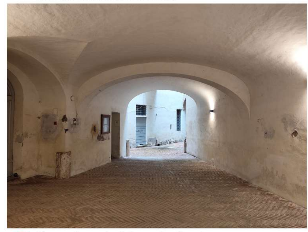
6 Seconda corte interna in direzione dell'ascensore: mancanza di informazioni orientative
