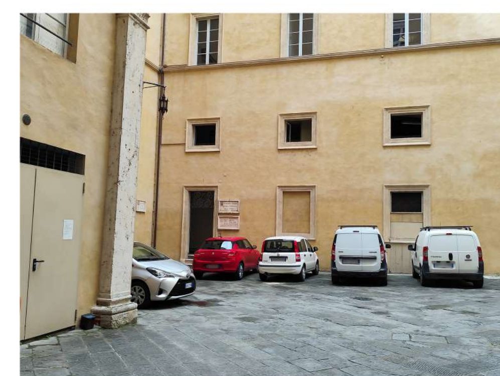
8 Posti auto riservati a utenti disabili non segnalati
