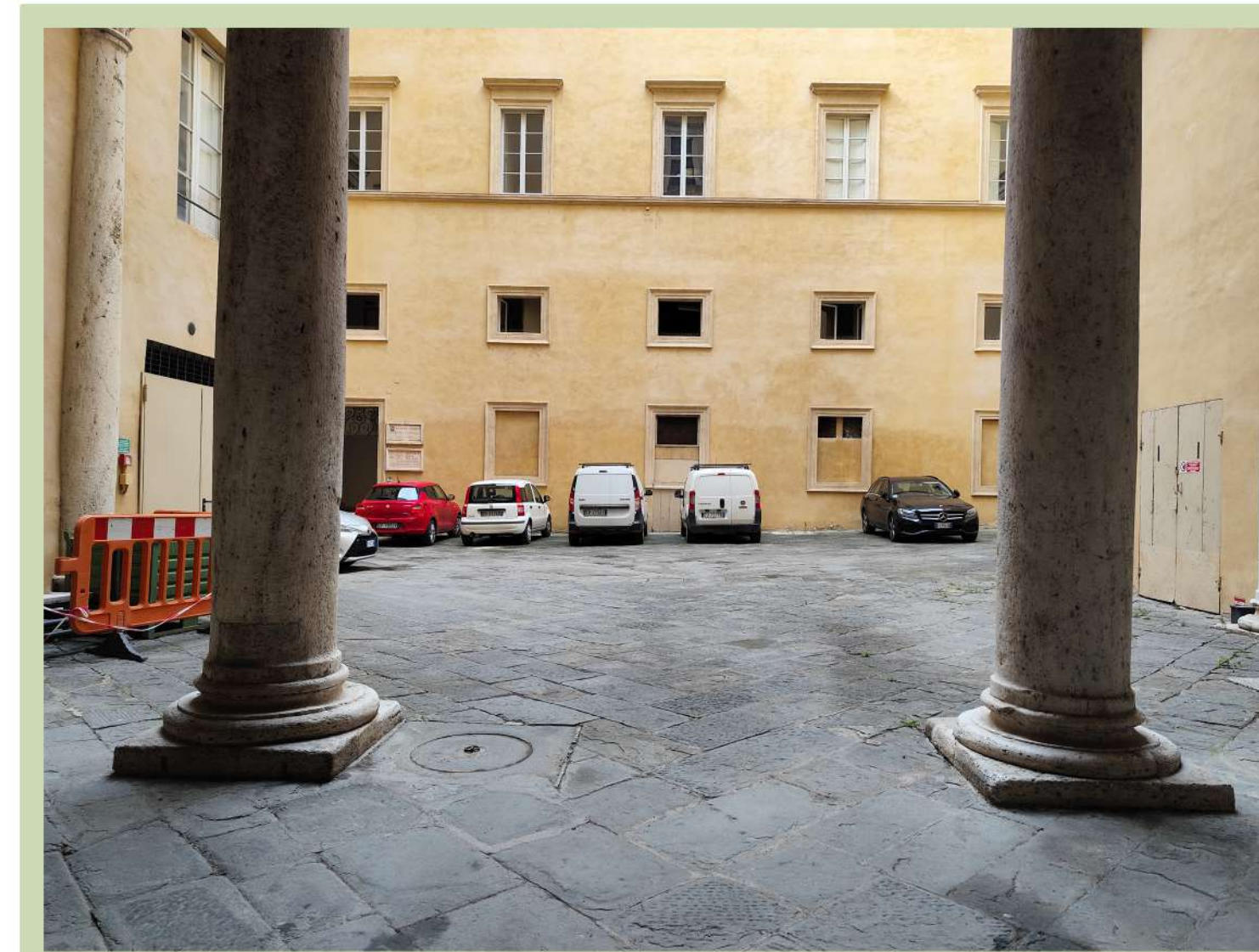
Gli utenti disabili hanno la possibilità di accedere in auto direttamente all'interno della corte, ove sono presenti dei posti riservati.
